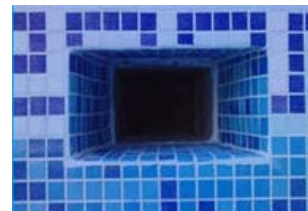
Pegado y sellado entre elementos de piscinas
