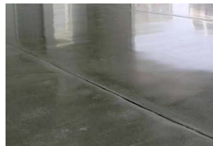
Juntas de pavimentos interiores transitables
